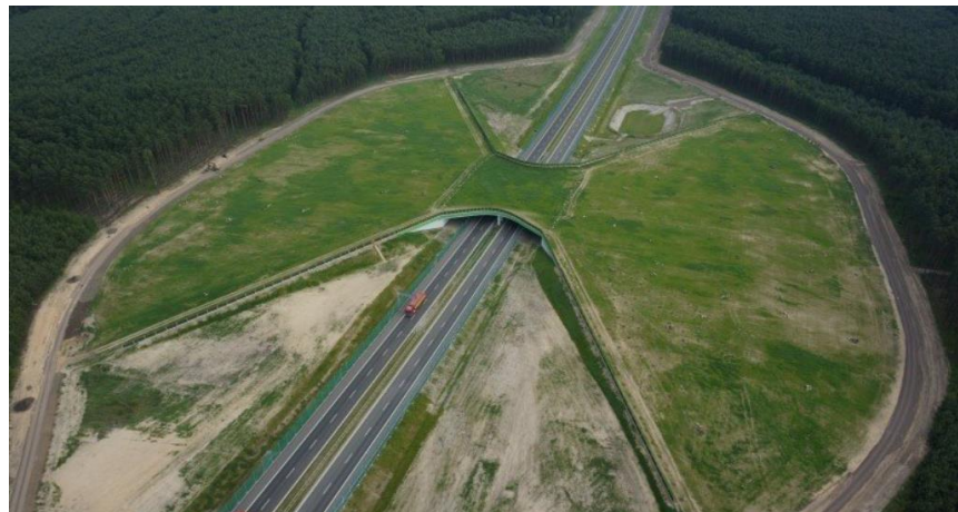
Przejście dla zwierząt nad drogą S3, na odcinku Gorzów - Międzyrzecz GDDKiA
