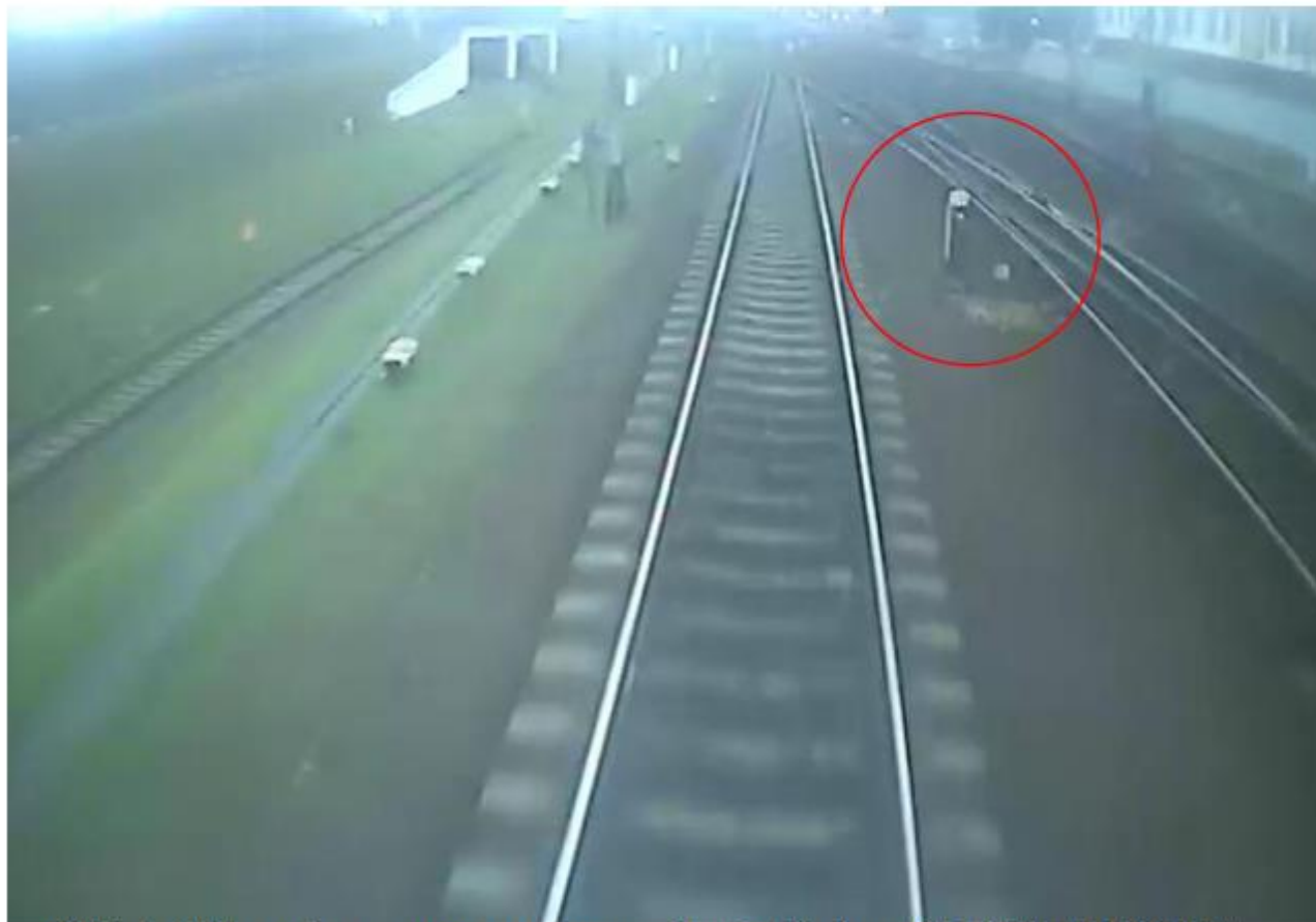
Zdjęcie 6 - Widok z autobusu szynowego tarczy manewrowej Tm30 nadającej sygnał Msl (źródło: POLREGIO S.A.)
